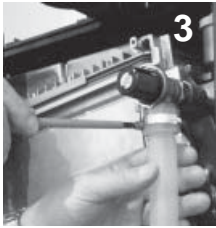
Montage Sicherheitsventil
